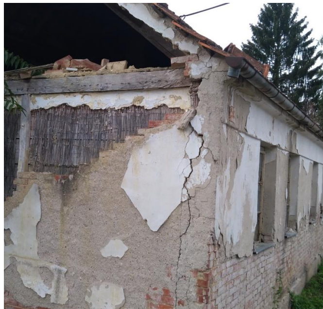
Slika 76. Primjer korištenja trske kao izolacijskog materijala u starim kućama u Zlataru
